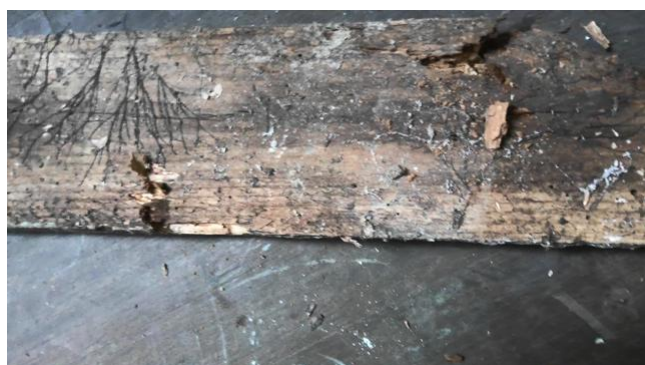
INS056 Maison - Séjour PH:20260223-021217 plinthe - bois (brut) Pourriture cubique (présence d'indice)
