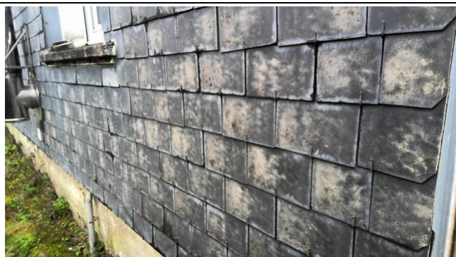
001 : amiante ciment EXTERIEUR/EXTERIEUR/Toiture (niv:0)
