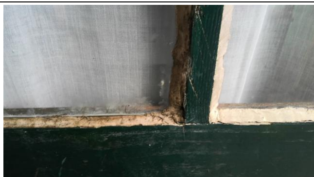
003 : joints de vitrage Véranda (niv:0)
