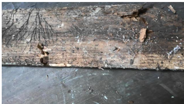
INS051 Maison - Séjour PH:20260223-021217 plinthe - bois (brut) insectes à larves xylophages (ILX) (présence d'indice)
