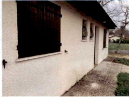
Photo n° PhA001 Localisation : Maison - Façades Ouvrage : Appuis de fenêtres Partie d'ouvrage : Eléments fibres-ciment Description : Eléments fibres-ciment
