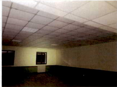
Photo n° PhA003 Localisation : Maison - Entrée/Séjour; Maison - Pièce 1; Maison - Pièce 2; Maison - Pièce 3; Maison - Cuisine; Maison - Point d'eau; Maison - Wc 1; Maison - Wc 2 Ouvrage : Flocages, Calorifugeages, Faux plafonds Partie d'ouvrage : Faux plafonds Description : Faux plafonds
