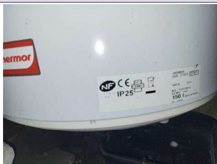
Photo PhDPE001 Ouvrage : ECSanitaires Description : Txt_nb_niveaux
