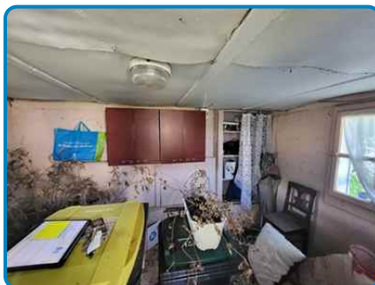
Maison principale Rez de chaussée Débarras
