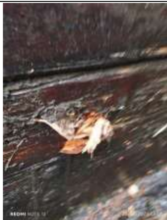
Photo n° PhTer002 Localisation : Abris jardin Ouvrage : Mur - Bois
