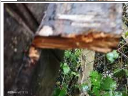
Photo n° PhTer002 Localisation : Abris jardin Ouvrage : Mur - Bois
