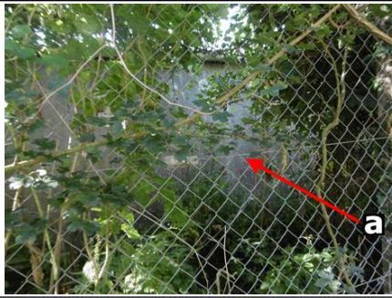
Photo n° PhA001 Localisation : Rez de chaussée - Voilière Ouvrage : Bardages et façades légères Partie d'ouvrage : Plaques (fibres-ciment) Description : Plaques (fibres-ciment) Localisation sur croquis : M001
