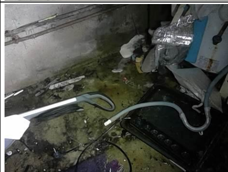
Photo n° PhTer002 Localisation : Rez de chaussée - Garage Ouvrage : Sol Informations complémentaires : Hygrométrie mesurée très élevée
