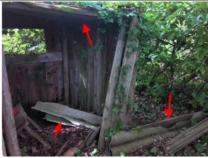
Photo n° PhA005 Localisation : Extérieur - Cabanne Ouvrage : Toitures Partie d'ouvrage : Plaques (fibres-ciment) Description : Plaques (fibres-ciment) Localisation sur croquis : M005
