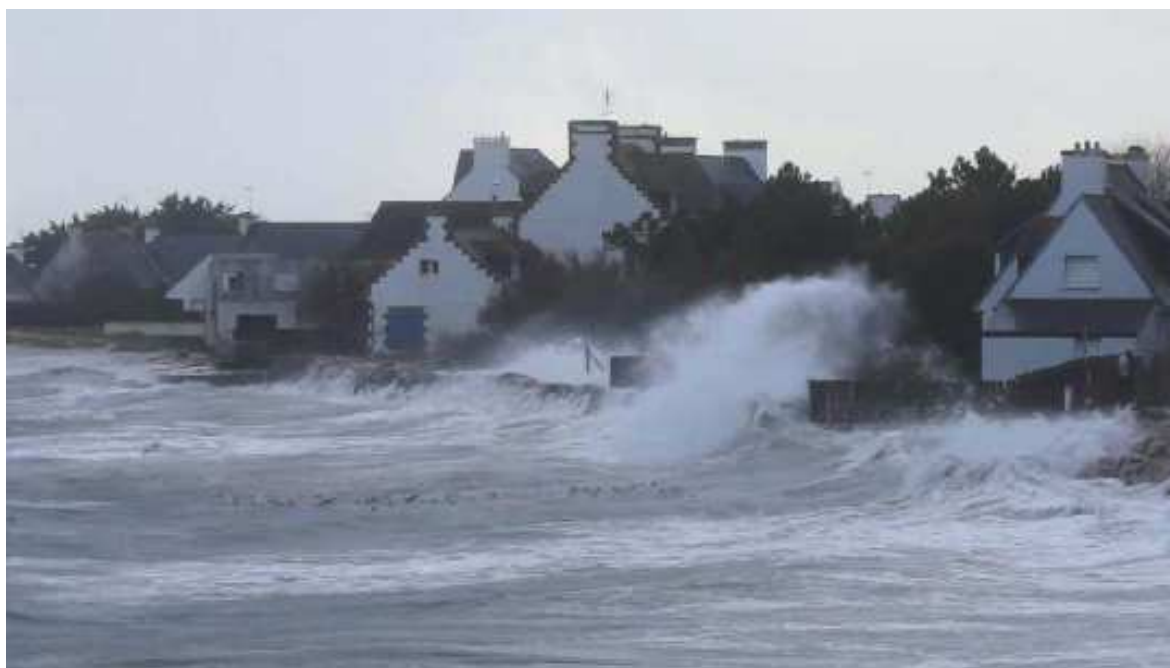
Franchissements observés au niveau du Port du Larvor le 1 er janvier 2014 – commune de Loctudy (capture réalisée à partir d'une vidéo prise par la commune)
