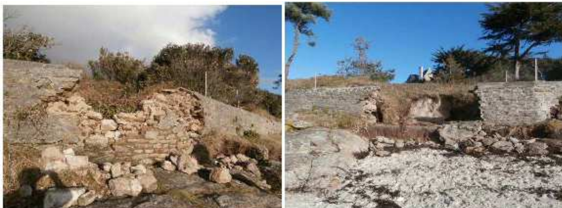
Murs privés endommagés au niveau de la plage du Large ( commune de Concarneau) – (photos réalisées par la commune lors de l'hiver 2014
