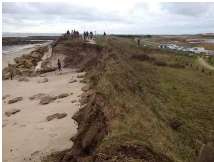
Disparition du chemin côtier et d'une grosse partie du cordon dunaire à l'est de la Pointe du Léhan (commune de Treffiagat) (photographie parue dans le télégrammes du 4 janvier 2014)
