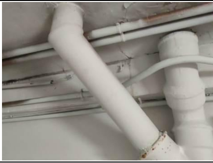
Photo n° PhA001 Localisation : Rez de chaussée - Chaufferie Ouvrage : 3. Conduits, canalisations et équipements intérieurs - Conduits de fluides (air, eau, autres fluides) Partie d'ouvrage : Conduits Description : Conduits
