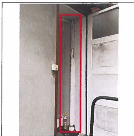
Photo n° FA002 Localisation : Extérieur - Façade Nord Ouvrage : Substrats et revêtements Partie d'ouvrage : Parties accessibles Description : Descente de pluie en fibrociment
