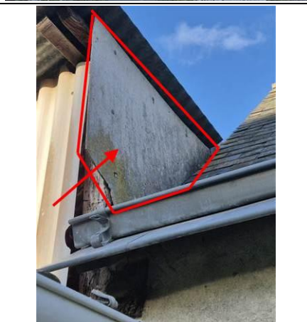
Photo n° PhA004 Localisation : Rez de chaussée - Garage Ouvrage : Bardages et façades légères Partie d'ouvrage : Plaques (fibres-ciment) Description : Plaques (fibres-ciment) Localisation sur croquis : D
