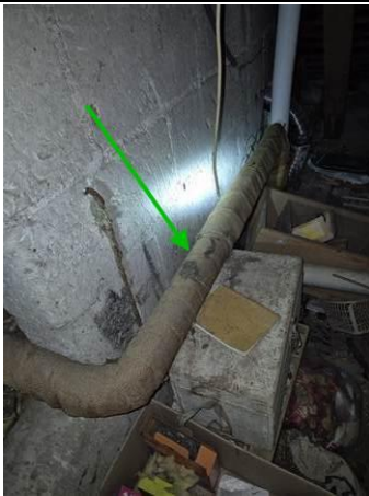
Photo n° PhA007 Localisation : Rez de chaussée - Entrée; 1er étage - Grenier 1; 1er étage - Grenier 2; 1er étage - Combles Ouvrage : Flocages, Calorifugeages, Faux plafonds Partie d'ouvrage : Calorifugeages Description : Calorifugeages Localisation sur croquis : G
