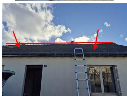
Photo n° PhA005 Localisation : 1er étage - Grenier 1; 1er étage - Grenier 2; 1er étage - Combles Ouvrage : Toitures Partie d'ouvrage : Plaques (fibres-ciment) Description : Plaques (fibres-ciment) Localisation sur croquis : E
