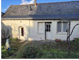
FACADE SUD. Photo réalisée le jour de la visite
