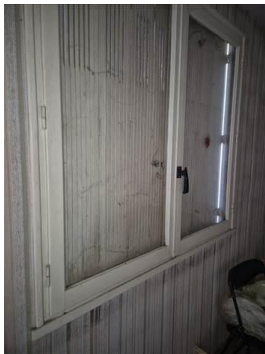
Menuiserie ancienne. Etat général : Moyen Photo réalisée le jour de la visite
