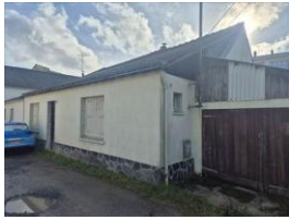
FACADE NORD et OUEST. Photo réalisée le jour de la visite
